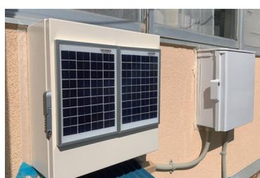
校舎壁面に設置した検知装置本体とソーラー UPS
